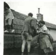
„Es war schon etwas Bizarres, als wir an Stelle der Dachplatte endlich wieder mal Ziegel unser Dach decken konnten“ (Wolfrum).
