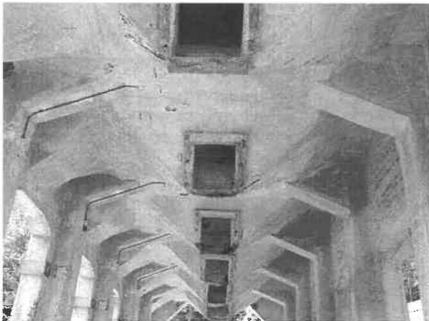
Blick auf das Gewölbe/ehem. Sortieranlage
