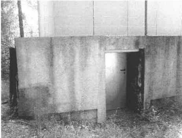
Eingang zum Stollen_2
