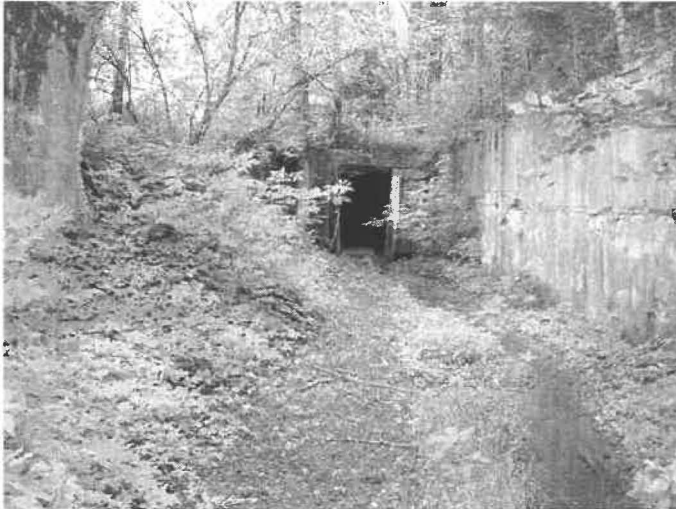
Zugang zum Stollen_1 über Waldweg
