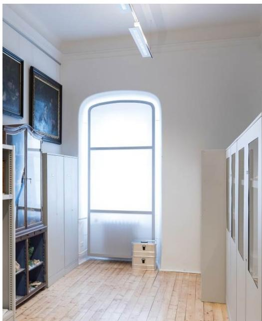
Abbildung 32: Rahmen, mit Lichtschutzstoff bespannt und in die Fensternische eingesetzt. Die Beleuchtung erfolgt über abgehängte LED-Paneele. Objektdepot 2017.
